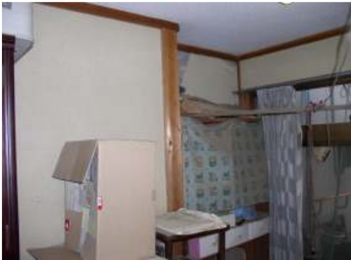
③ 以前は廊下の一部と押入れでした。
