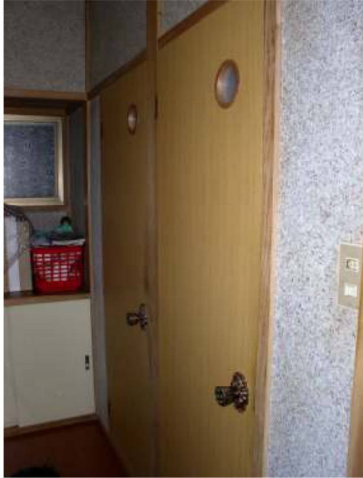
③ 1階トイレ 廊下側より
