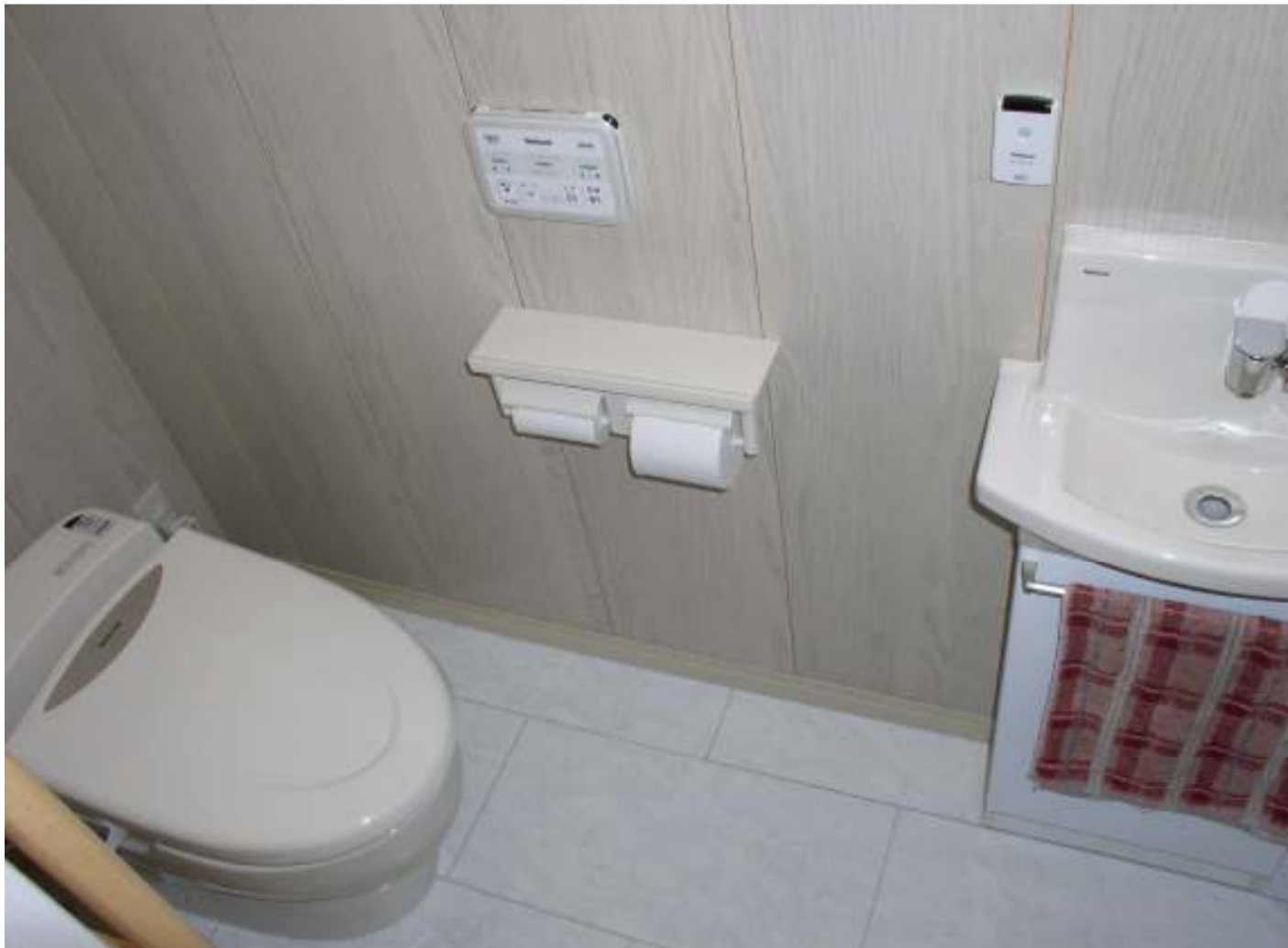
③ 小便器側と大便器側を1部屋にし、タンクレストイレの採用で広く使い易く。掃除も水廻りお奨め床材と、プリントの腰板で以前より楽に。また、便フタの自動開閉や手摺で安全に使いやすく。
