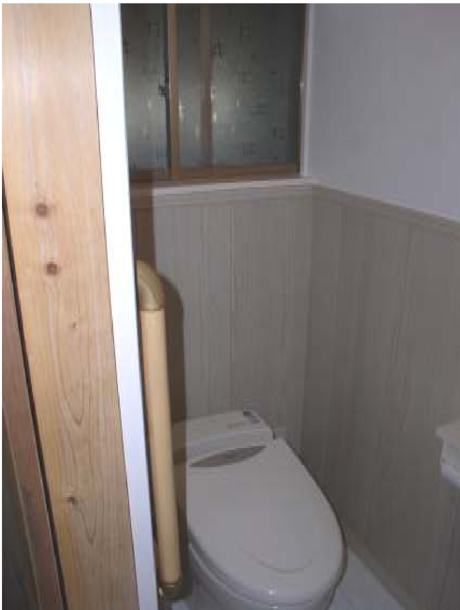
① 旧大便器側 圧迫感のないタンクレスの便器を採用
